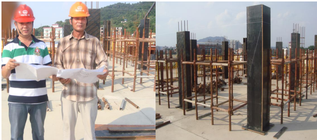
建设中的施工工艺样板墙
