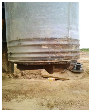
预应力混凝土管桩接桩
