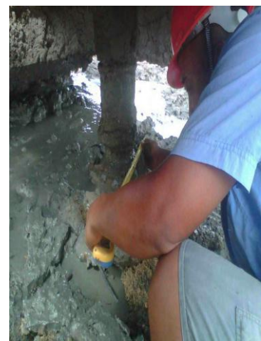
桩基钻头检测
