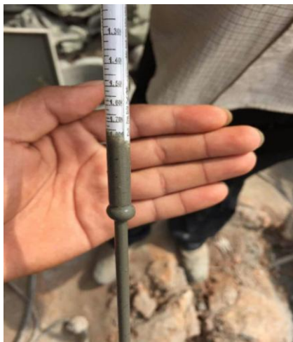
泥浆配比及检测
