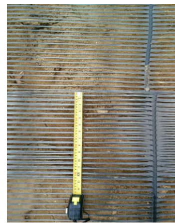
土工格栅铺设检查
